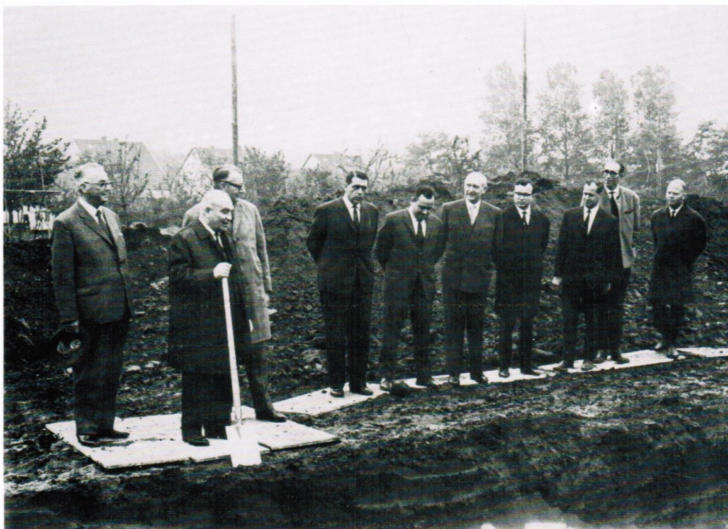
Der erste Spatenstich
